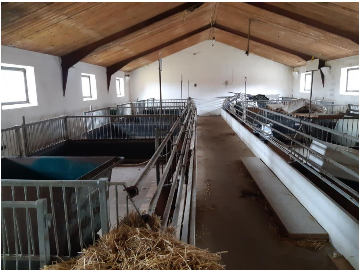
Gl. svinestald. Dybstrøelsesstald med fast gulv uden underliggende gyllekummer og foderkrybber til manuel fodring (bemærk fodervogn i venstre side). Stalden er desuden uden tidssvarende ventilationsanlæg.
